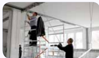
Kabel zurückbauen u. beschriften
